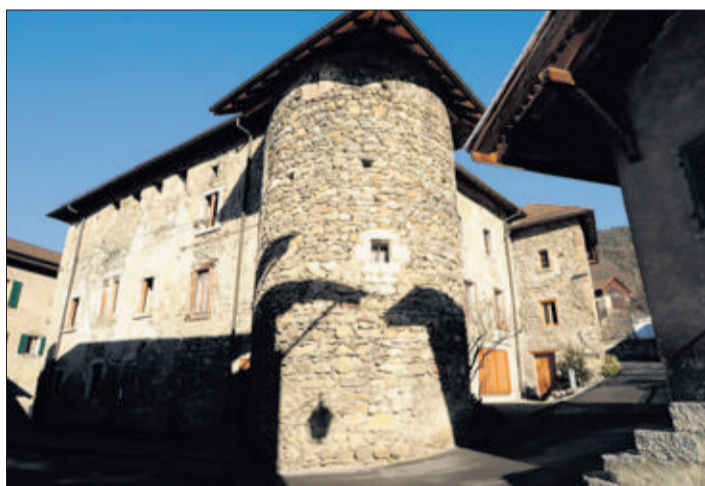
PAR SECTEUR Après de multiples travaux dans la partie est du château, la prochaine étape concernera l'aile sud entre 2008 et 2010.
