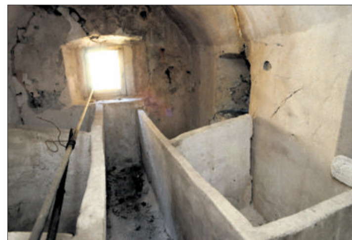
VESTIGES A chaque salle, son lot de découvertes! Ici, une ancienne salle de réserves. L'accès général aux pièces sera amélioré, notamment via des escaliers «à l'italienne».
